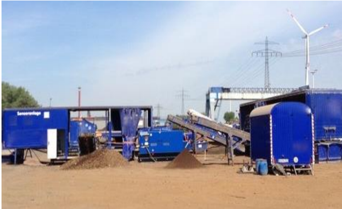
Mobile Aufbereitungsanlage für die Sortierung von Kehrlicht in einem deutschen Stahlwerk
