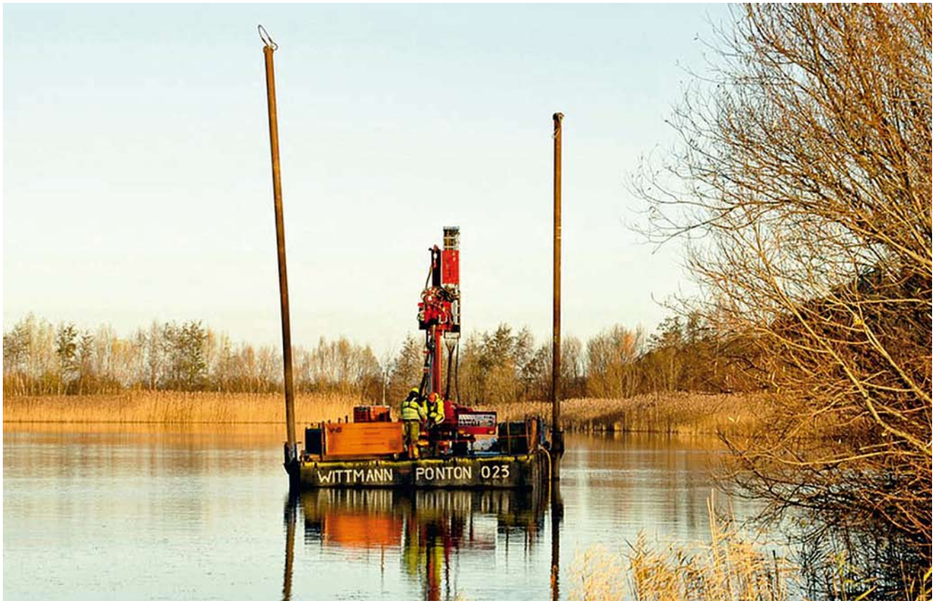
Schlammrückstände des einstigen Erzbergwerks Rammelsberg im Harz enthalten wertvolle Rohstoffe. Von einer Bohrinsel aus nehmen Forschende Proben
